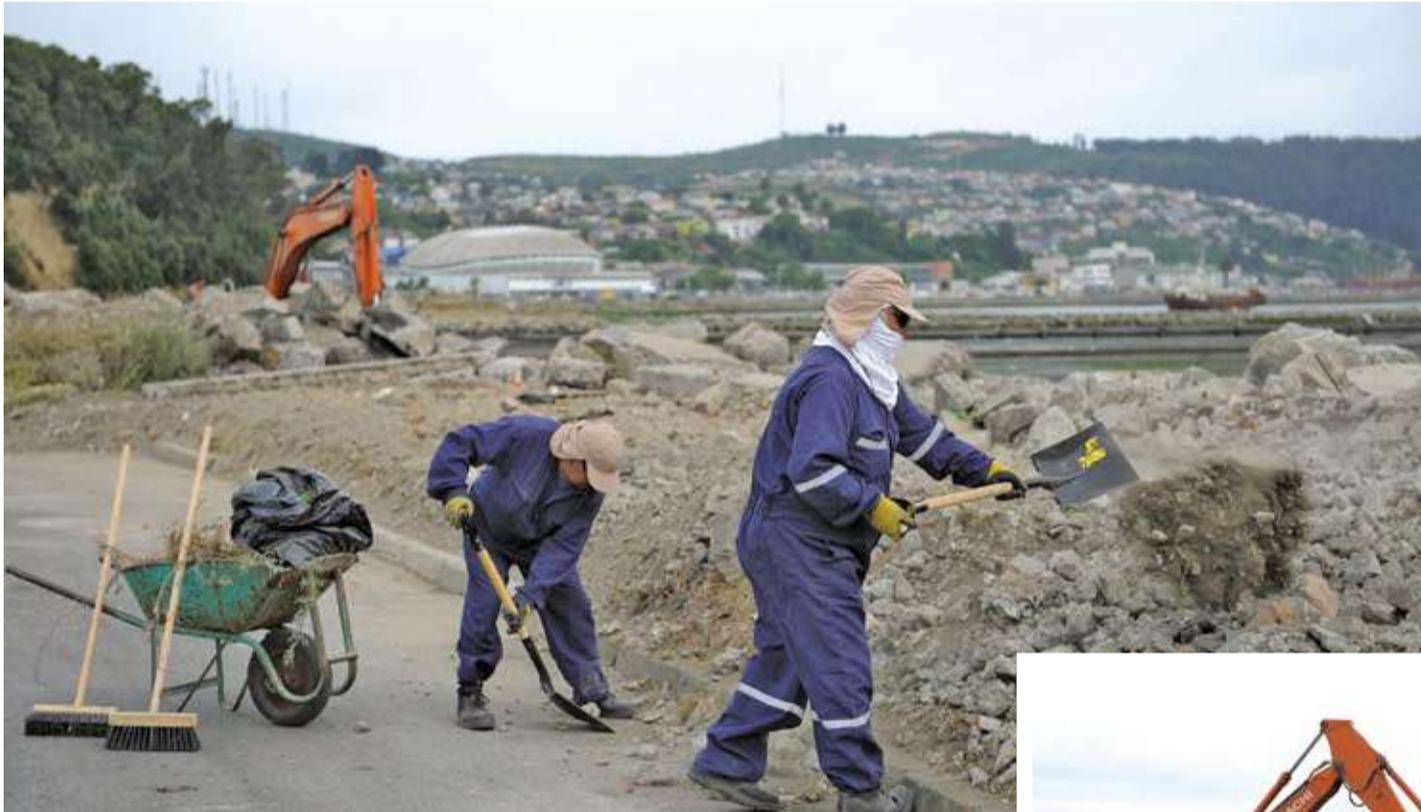
En una primera etapa, las obras consistieron en la limpieza de 310 metros lineales de borde-playa; retiro de basura; desmalezado y reordenamiento del enrocado.
